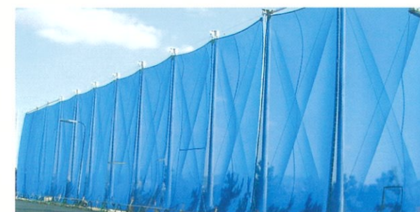
■テント・ネット 構造物テント倉庫、防塵ネット
