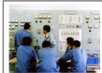
電力機器実習
