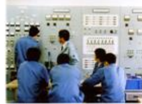
電力機器実習
